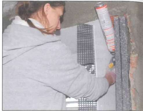
Aufbringen des Montageschaumklebers
