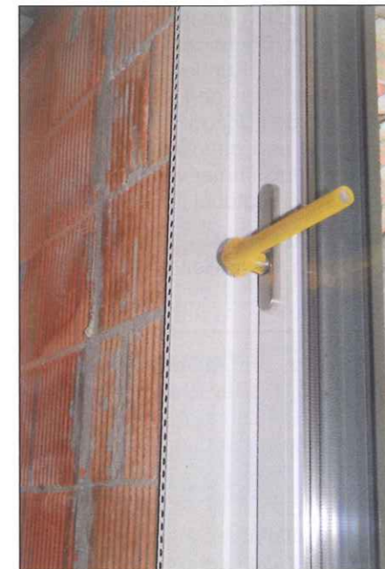
Laibungsplatten schützen Fensterrahmen und Beschläge vor Verschmutzung und Beschädigung
