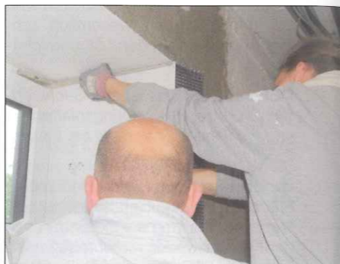
Winkelgenaues Ausrichten und Fixieren (Fotos: PRM)
